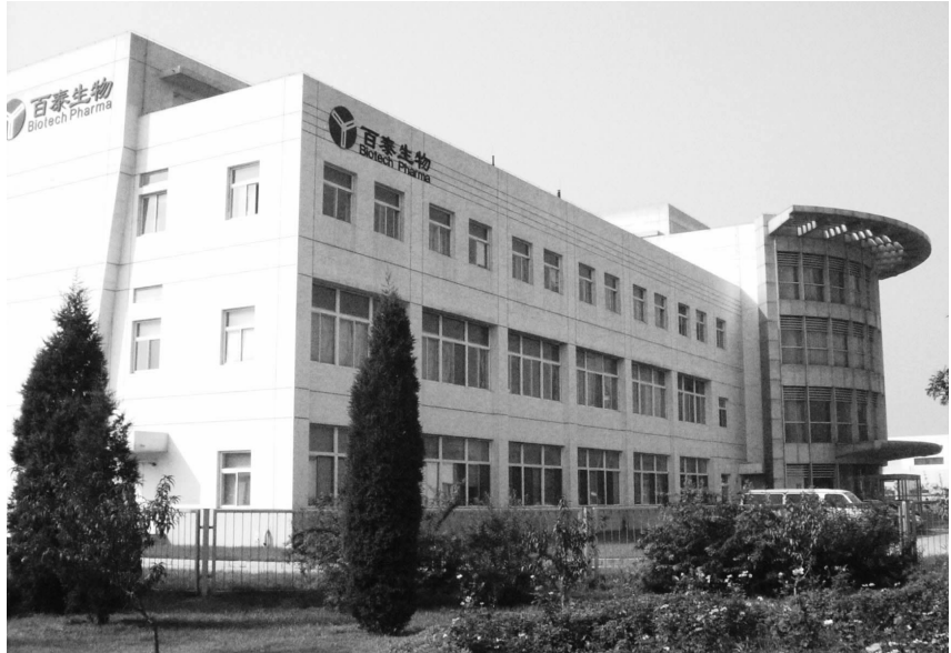
位于北京经济技术开发区的百泰生物药业有限公司
