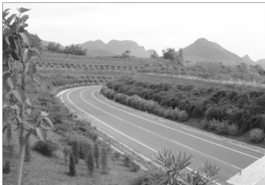
膨胀土边坡柔性支护综合处治技术在广西南宁至友谊关高速公路建设中得到应用
